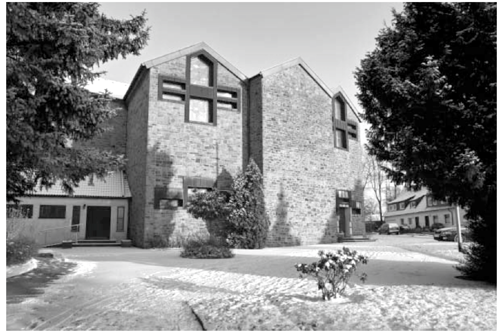
1962 - Energetisch und sturmsicher umgebaute Kirche
